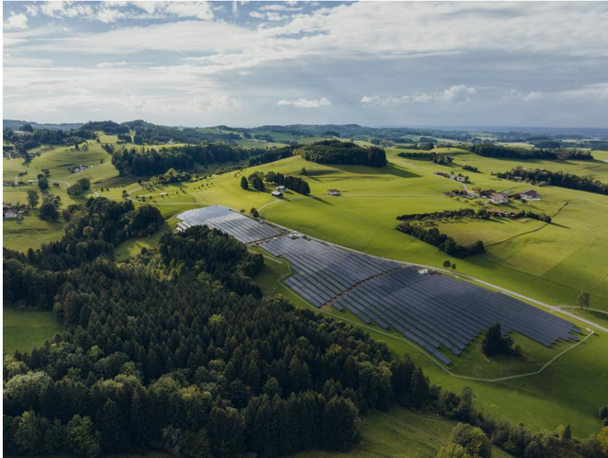
Abbildung 20 | PV-Freiflächenanlage Wiggensbach Hinlings (Quelle: Philip Herzhoff).
